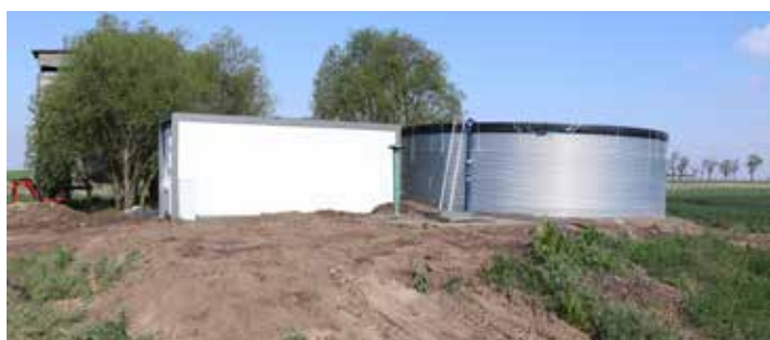
Fot. 2. Budynek sterowni oraz zbiornik na wodę
